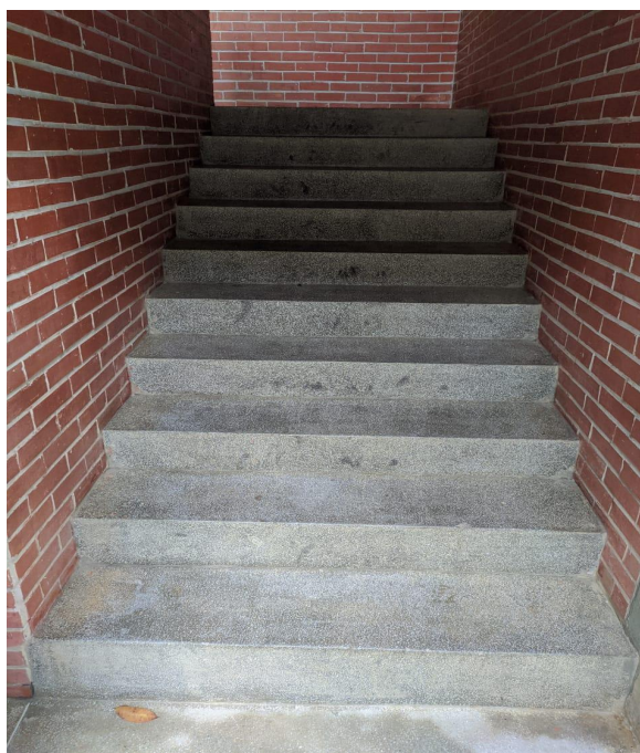
Figura 1: Unidade de Mamanguape. Largura da escada: 1,33.
