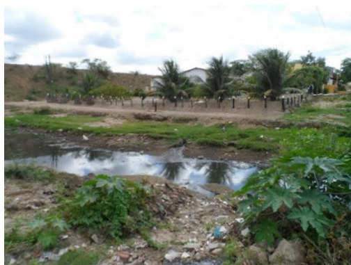
Fig. 15 – Mata ciliar removido para construção civil e lançamento de esgoto no leito do rio. Data: 28/03/2014. Foto: Lucíola Cordeiro.
