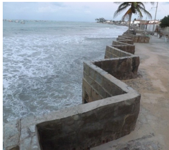
Figuras 42: Método de contenção, quebra-mar misto. Foto: Tirada pela autora, 2016
